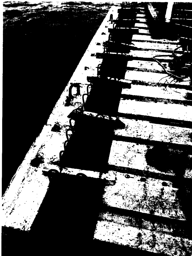
FOTO 11: Encofrado en la zona del cabezo
